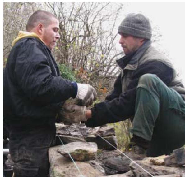
Trockenmauerbau: Teilnehmende bei der Arbeit
